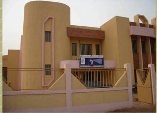
Maison de formation des élus locaux
